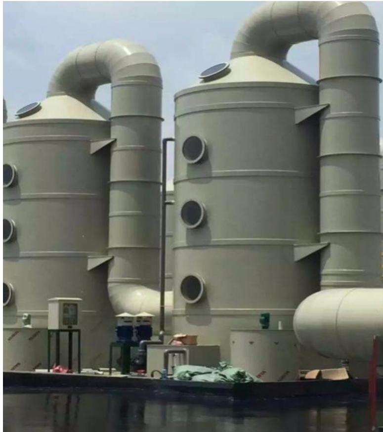
图 6.3-2 生物除臭塔装置图
