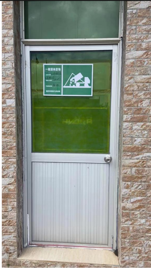
图 10 一般固体废物暂存间现状图片
