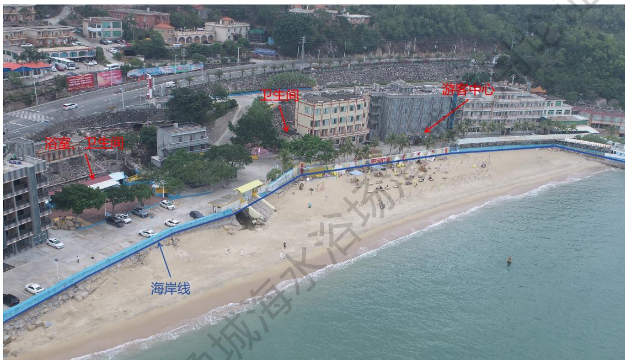
图1.3-2 项目现场照片
