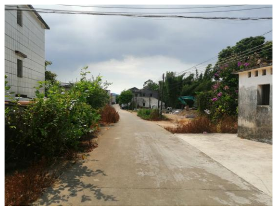
拟扩宽路肩道路现状
