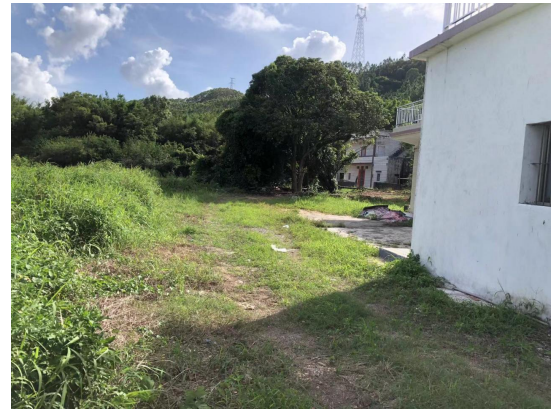
拟建砼路面道路现状
