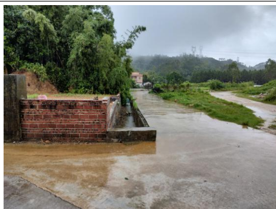
拟建砼路面道路现状
