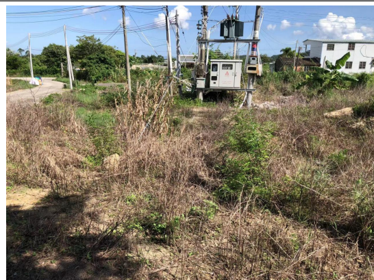
拟建路灯道路现状
