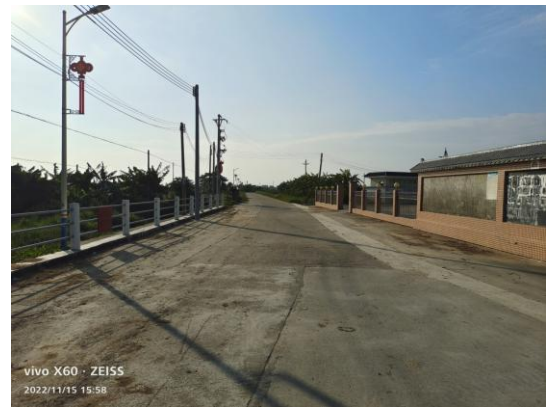
保和里重建砼道路现状
