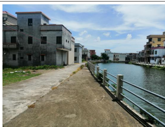
重建砼挡墙及栏杆现状
