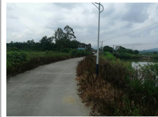
拟扩宽路肩道路现状
