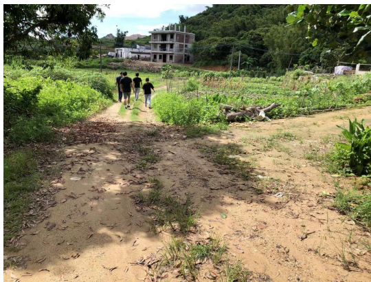
拟建砼路面道路现状
