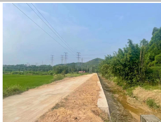
拟扩宽村道路肩现状
