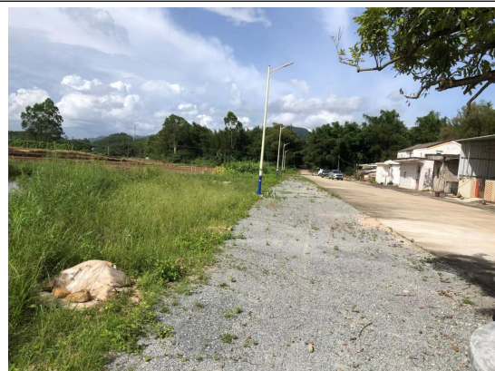
拟建砼地坪道路现状
