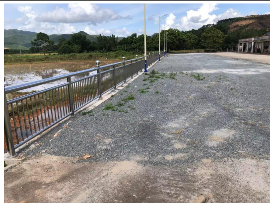
拟建砼路面道路现状
