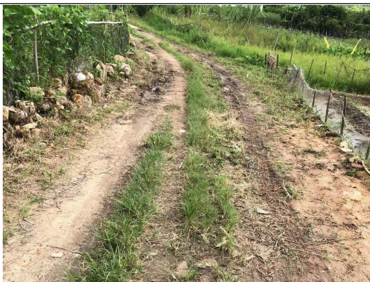
拟建砼路面道路现状
