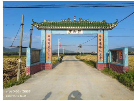
保和里重建砼道路现状
