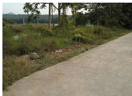
拟建砼地坪道路现状
