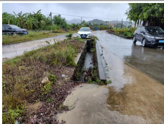
拟建砼路面道路现状
