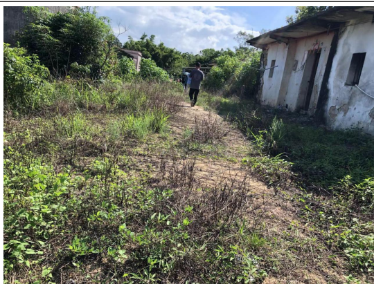
拟建砼路面道路现状
