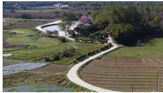
拟路灯沿线现状
