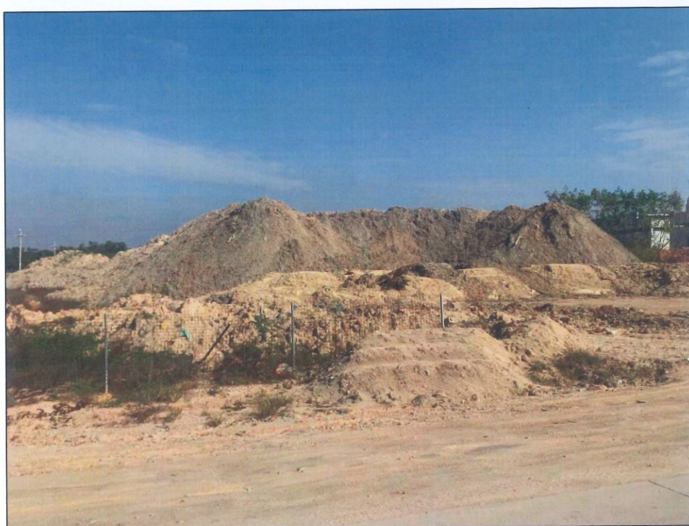
照片 2 堆场现状
