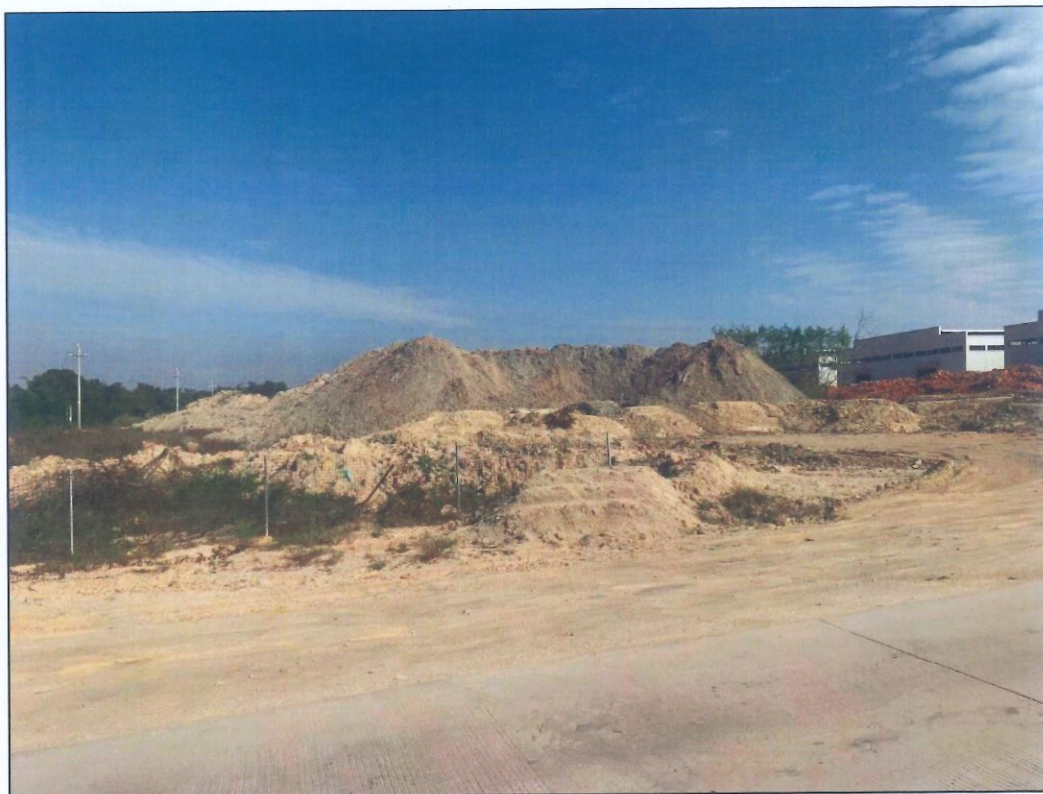
照片 1 堆场现状
